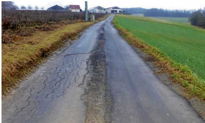
Feldweg bei Krautheim-Oberndorf, vor und nach der Modernisierung Foto: LRA Hohenlohekreis
